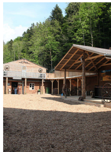
HSR-Arena im Western-Style
